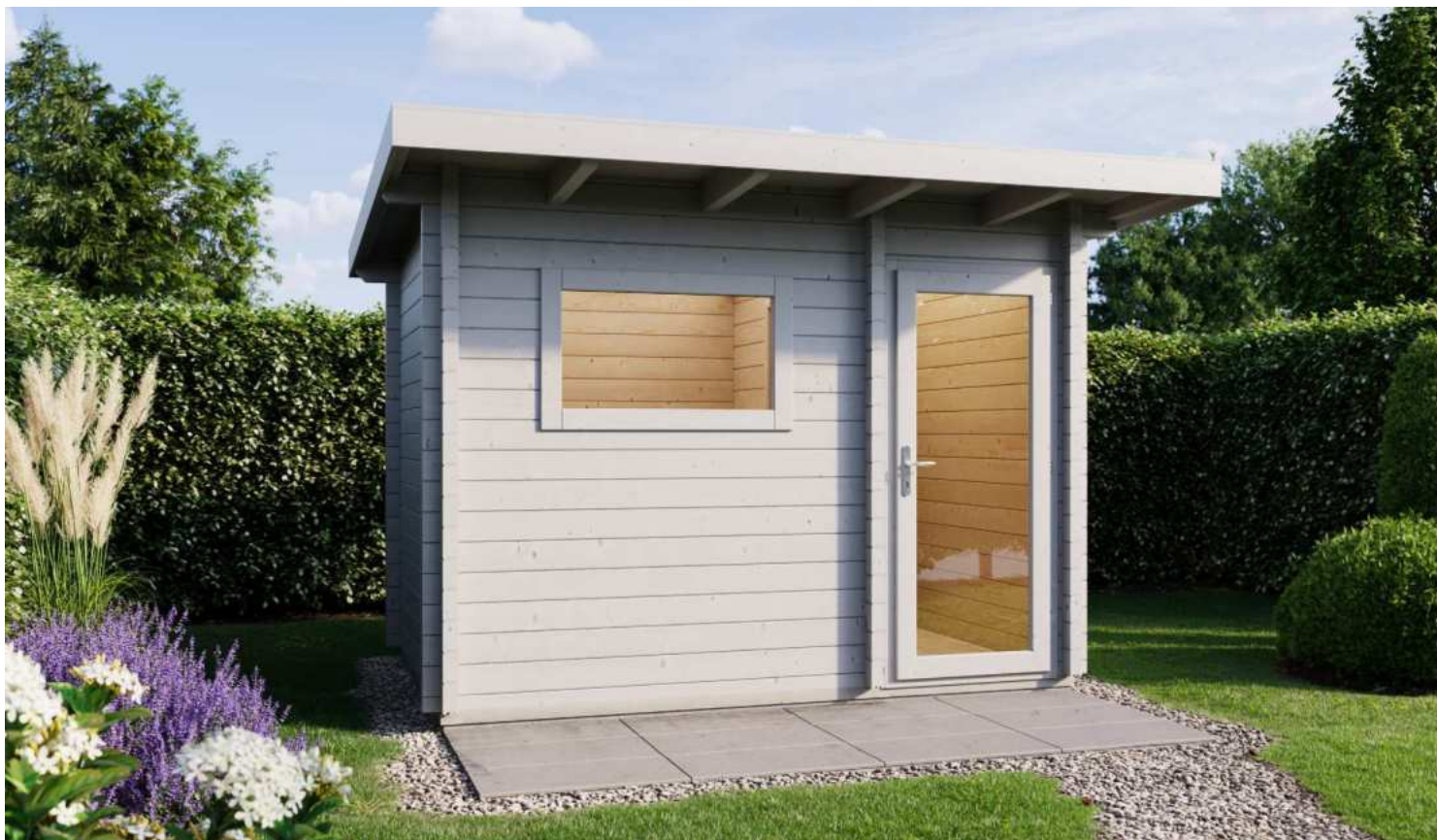
Abb.: Gartensauna TERRA 2, Farbanstrich bauseits
